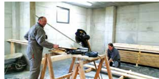
▲ Aménagement locaux S.T. ▼
