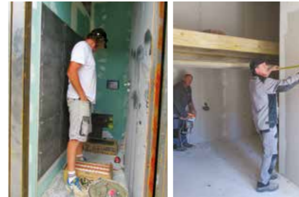
▲ Toilettes publiques Onclaire
