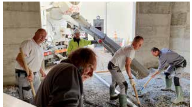
▲ Réalisation dalle du porche des locaux ST ▼
