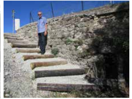
▲ Création escalier en rondin entre Chemin du Pont et Chemin Pavillon
