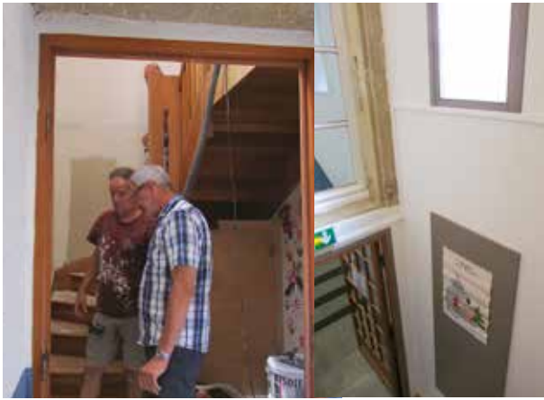
▲ Rénovation de la cage d'escalier École de Masneuf
