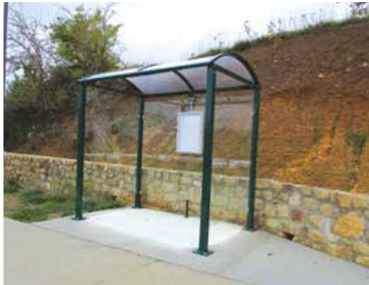
▲ Réalisation de dalles béton pour implantation des abris bus
