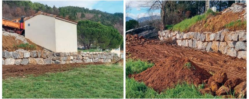
▲ Reprise mur soutènement par enrochement zone arrêt, chemin Masneuf
