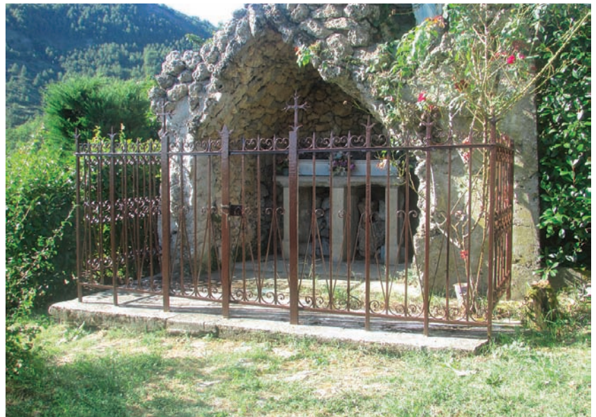
▲ Remise en état de la grille statue de la Vierge
