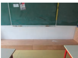
▲ Réalisation d'une estrade à l'école de Masneuf
