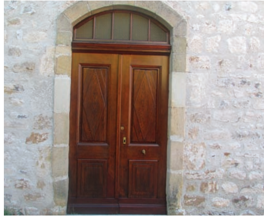
Remise en état de la porte de l'église
