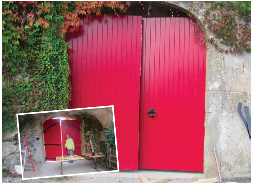
▲ Création d'un nouveau portail en bois au Camping
