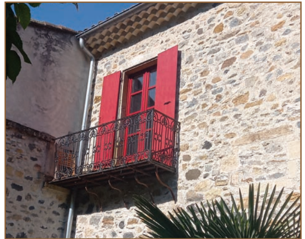
▲ Remise en état des volets du bâtiment communal du camping
