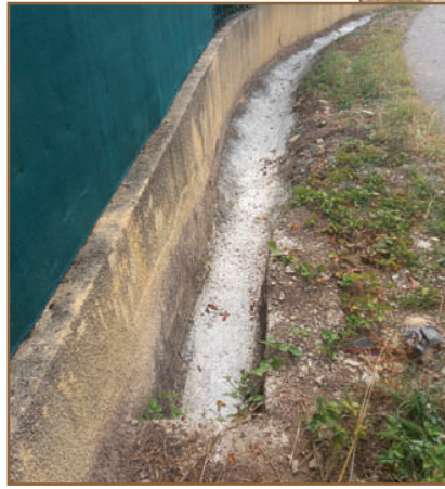
▲ Évacuation eaux pluviales
