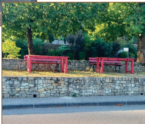
▲ Travaux implantation table et poubelle
