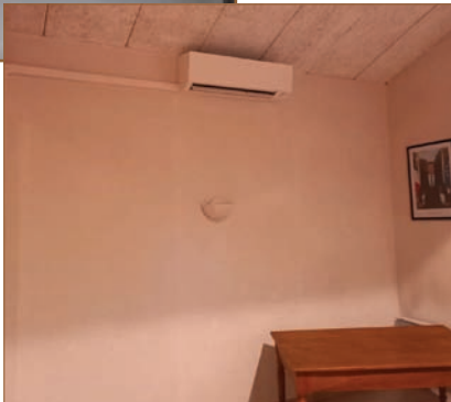
▲ Mise en place système de chauffage réversible
