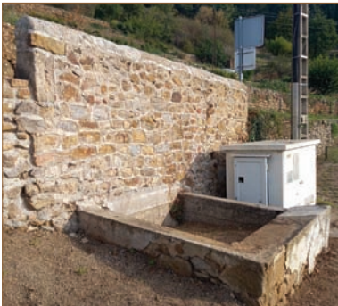
▲ Nettoyage transfo Masneuf
